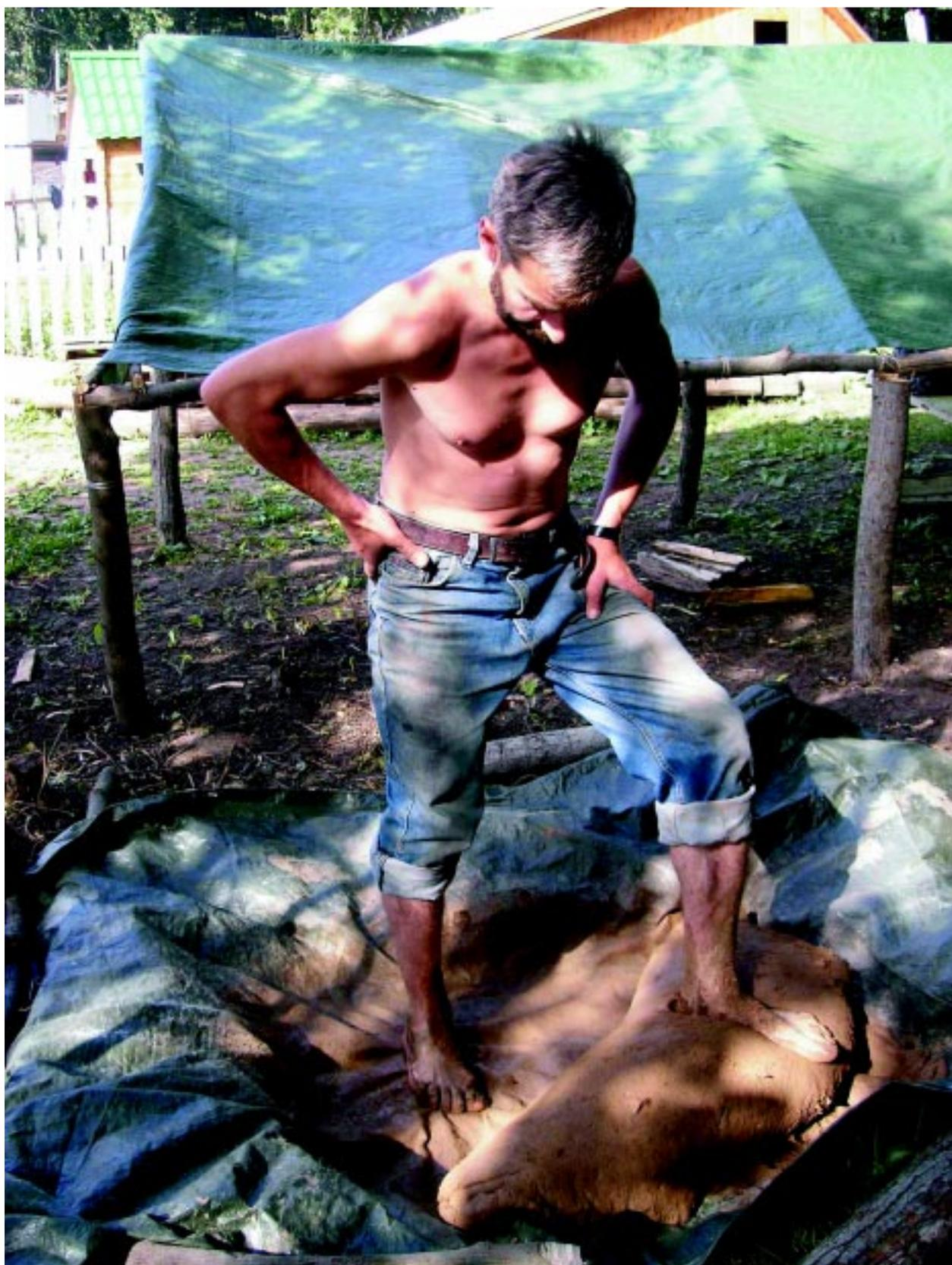
**Рис. 1.** Подготовка формочной массы для строительства гончарного горна
