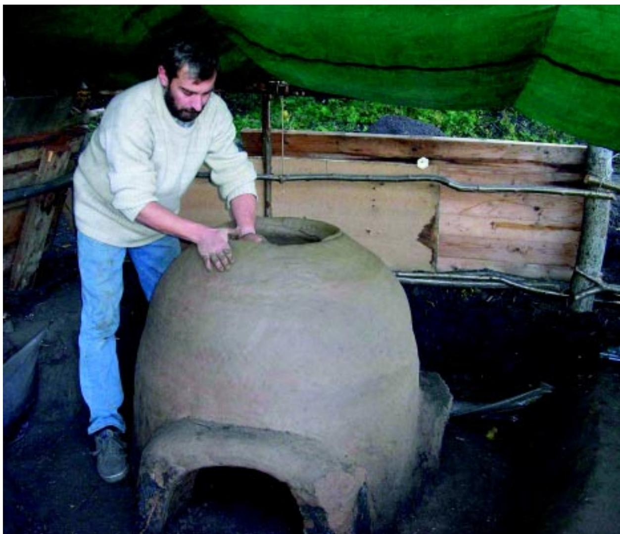
**Рис. 3.** Формовка жгутовым налепом купола обжиговой камеры
